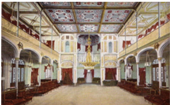
Fig. 3. The main hall, Kurhaus Băile Herculane
